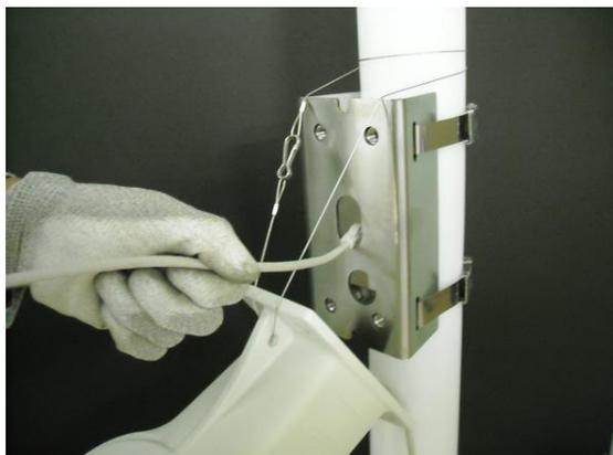
2. ハウジングユニットを保持しながら、ハウジング固定板に六角ネジ（M10x25） 4 本で固定する。
