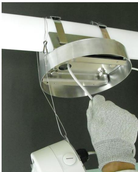
2. カメラを保持しながら、日よけの中のカメラ取付板にカメラをネジ (M4x10, x4) で取り付ける
