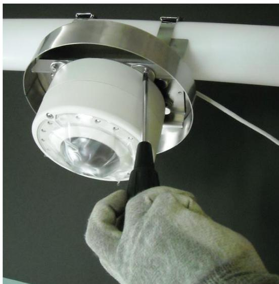
3. カメラを 3 本のネジでカメラ取付板に仮止めした後で、落下防止ワイヤーを取り外し、残りのネジ 1 本も含め 4 本を締め付ける。
